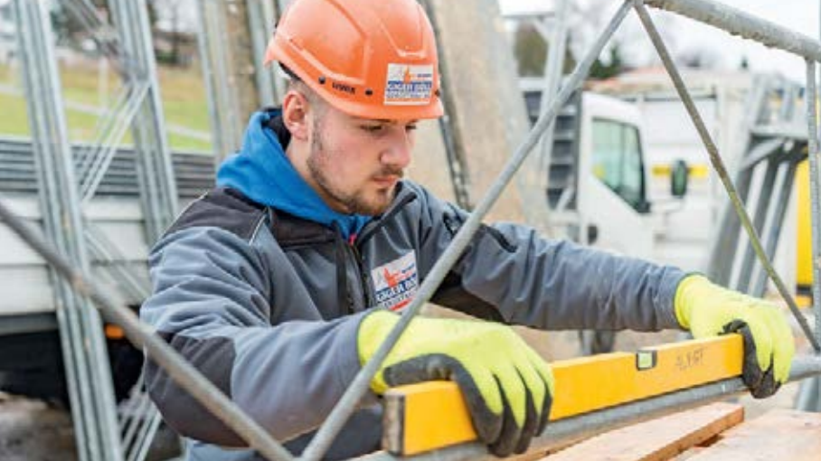
◀ Sinisa Vukman vérifie, à l'aide d'un niveau à bulle, que le cadre est bien droit.
